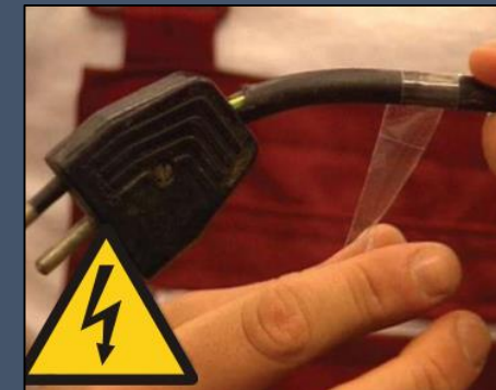
Evitare riparazioni Non conforme
